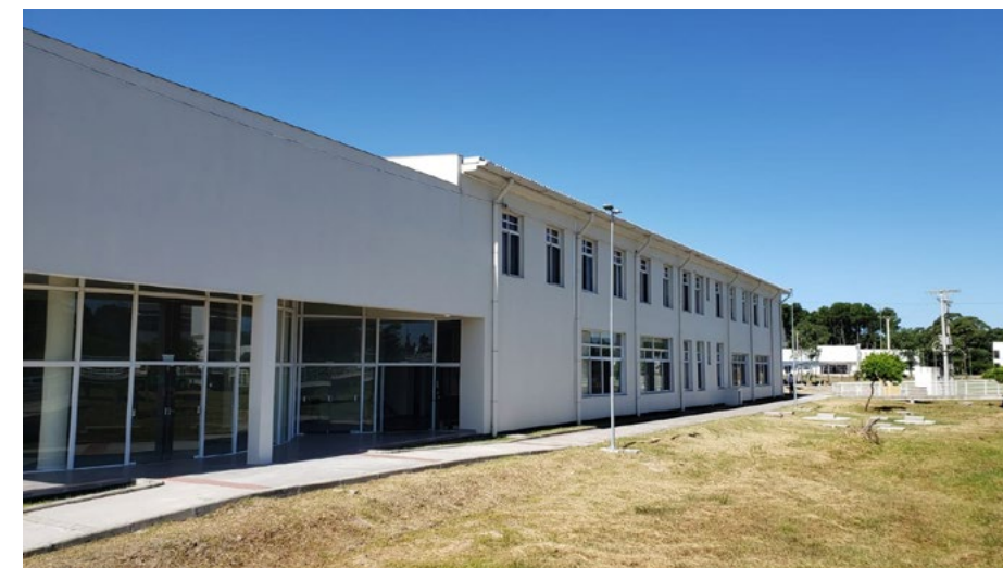
Prédio do Instituto de Educação (IE) Imagem: PROINFRA/DOB
