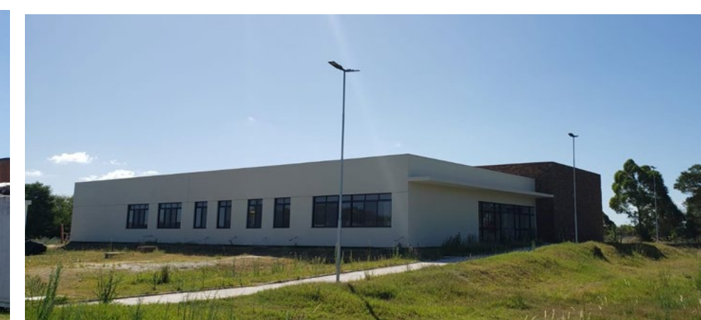
Prédio da Pró-Reitoria de Extensão e Cultura (PROEXC - TEIAS) Imagem: PROINFRA/DOB
