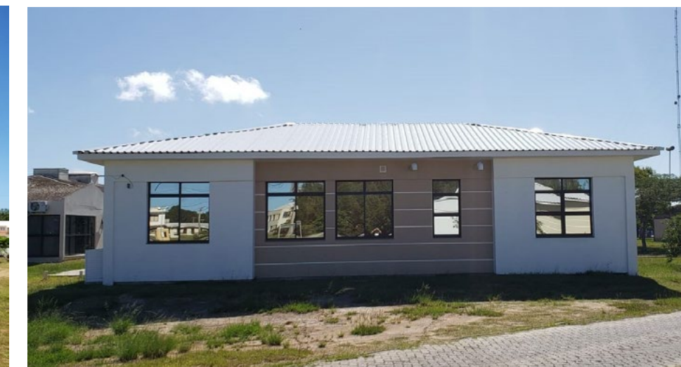
Ampliação do Laboratório de Aves Aquáticas e Tartarugas Marinhas (LAATM - ICB) Imagem: PROINFRA/DOB
