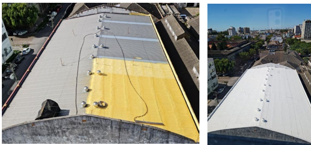
Isolamento Térmico-Hídrico na cobertura do Almoxarifado Central Fonte: GAD HU-FURG
