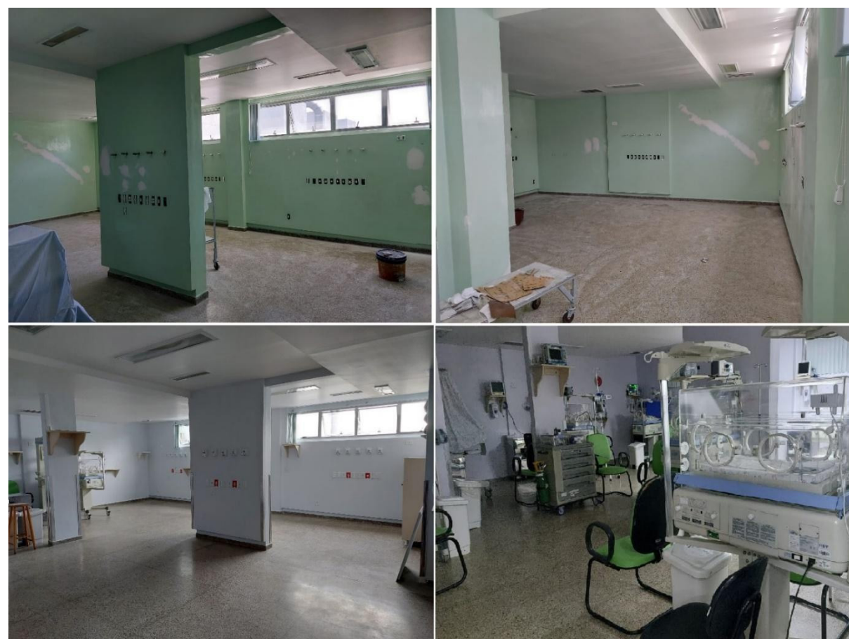
Reparação nos leitos de isolamento na UTIN HU-FURG/EBSEH.
