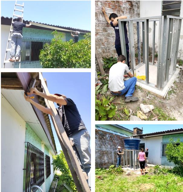
Figura 4 – Fixação da estrutura à base, colocação de calhas e conexão com o reservatório
