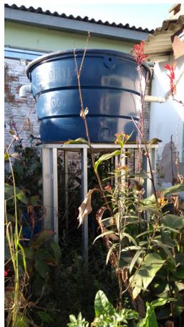
Figura 4 – Coletora de água da chuva na COHAB Tablada
